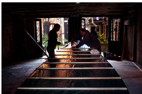
La costruzione del tiemo per il sandolo Vio
